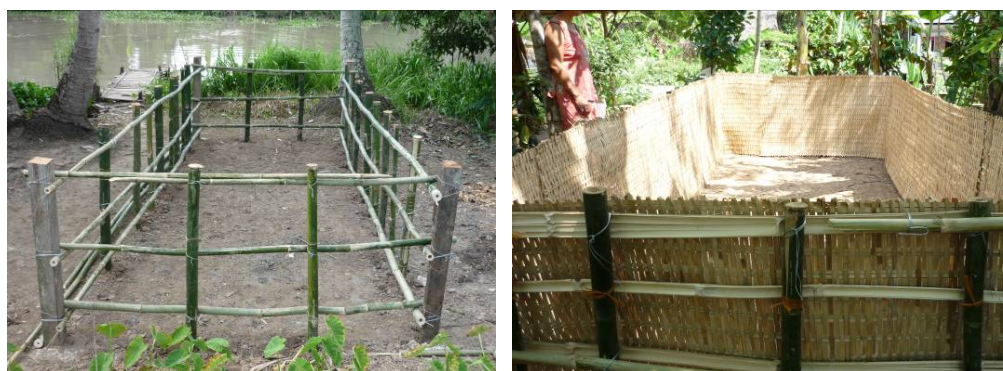
Hình 1: Khung bể làm bằng gỗ tạp, tre và mê bô
